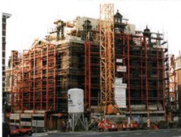
Travaux en cours
