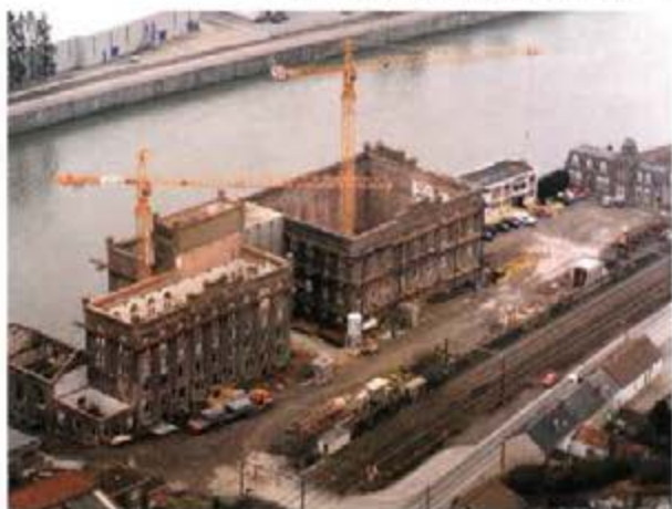
Travaux en cours
