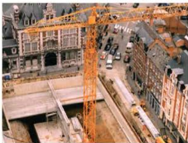
Travaux en cours
