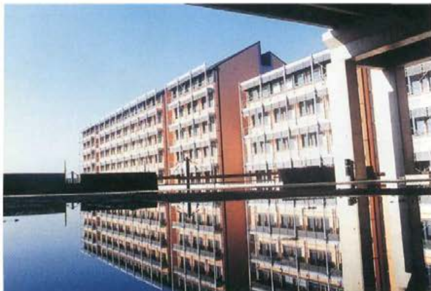
La dalle de la gare vue par le photographe Denis Tombal, La Meuse
