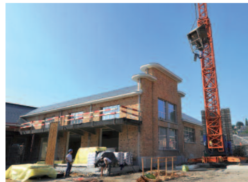
Vues globale du site, lors d'une visite de chantier fin octobre 2013. Le travail de gros œuvre se termine. Les bâtiments ont gardé le cachet architectural si reconnaissable, tout en bénéficiant d'une rénovation particulièrement performante au niveau énergétique. De nouvelles baies vitrées, une isolation du sol, des murs et des plafonds feront de ce bâtiment un modèle du genre.
