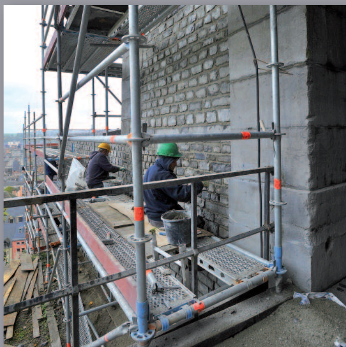
Photos : chantiers de rénovation de la Porte de Médiane
