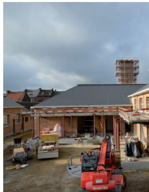
Vues globale du site, lors d'une visite de chantier fin octobre 2013. Le travail de gros œuvre se termine. Les bâtiments ont gardé le cachet architectural si reconnaissable, tout en bénéficiant d'une rénovation particulièrement performante au niveau énergétique. De nouvelles baies vitrées, une isolation du sol, des murs et des plafonds feront de ce bâtiment un modèle du genre.
