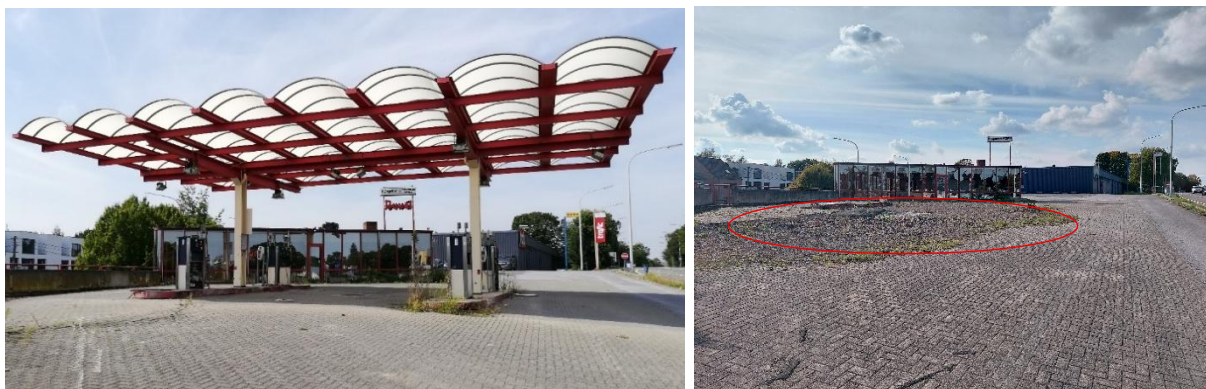
Figure 9 : Station-service en 2019 (à gauche) et traces de son ancienne implantation à l'état actuel (à droite) (ARIES, 2025)
