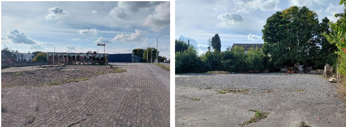
Figure 10 : Revêtement de sol côté station essence (à gauche) et revêtement de sol côté zone de livraison (à droite) (ARIES, 2025)
