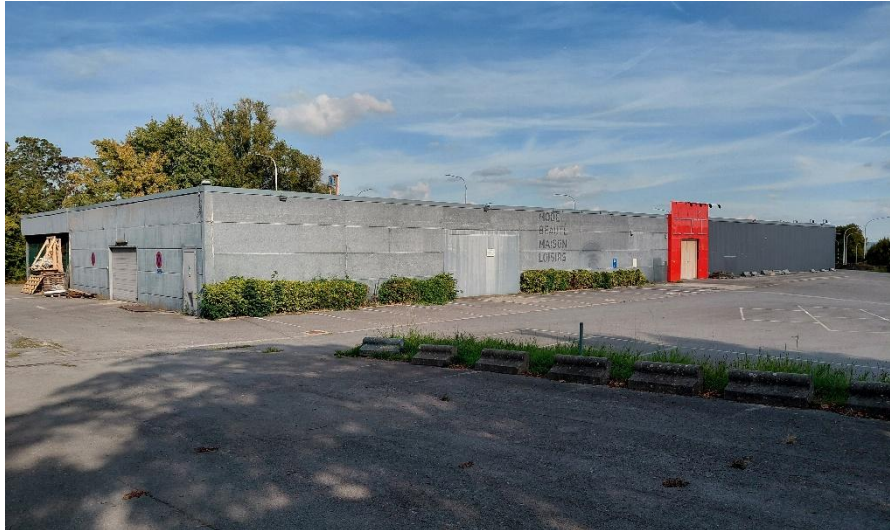
Figure 5 : Façade principale côté avenue Jean Pochet (ARIES, 2025)
