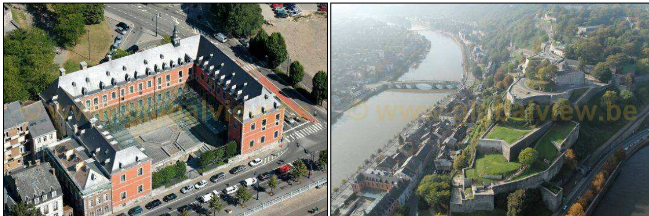
Illustration n° 21 : Vues aériennes du Parlement wallon et de la Citadelle - Monument et site classés (Source : Globalview)
