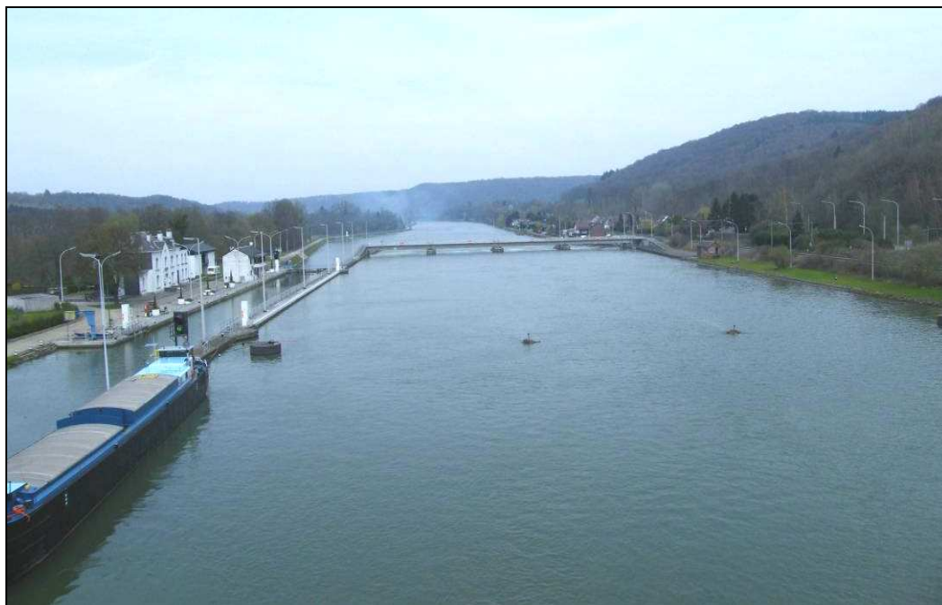
Illustration n° 68 : Paysage en aval du Pont-Route de la N947b (source : JNC AWP)
