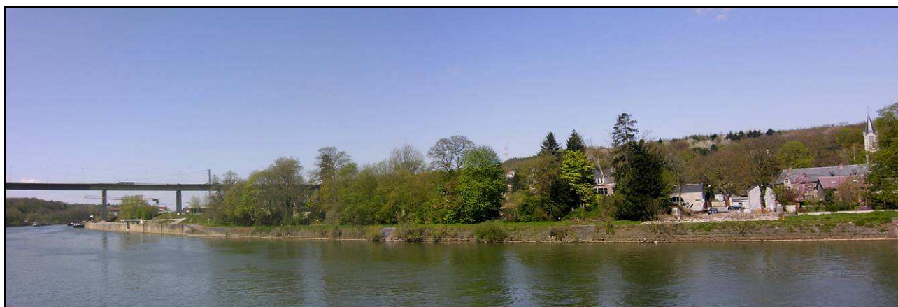
Illustration n° 6 : Viaduc et village de Beez depuis la rive gauche (photo : JNC AWP, 2008)
