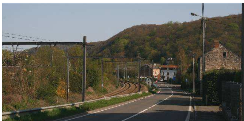
Illustration n° 65 : Vue de la RN 947 (photo JNC AWP)
