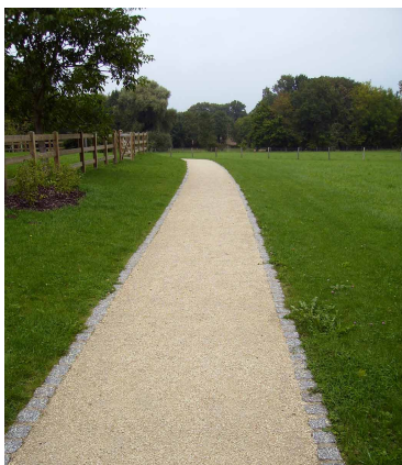
Cheminement avec un revêtement poudzollanique
