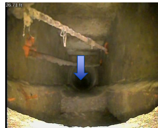
Photo du renforcement
